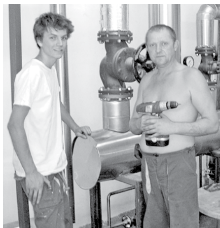
Sur le chantier de la conserverie D'Aucy à Timatchevsk.
